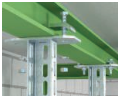
Прямое крепление к стальной конструкции Прямое крепление U-образной подвесной стойки с помощью фиксирующего угла KWS. Направление прокладки трассы вдоль балок.
