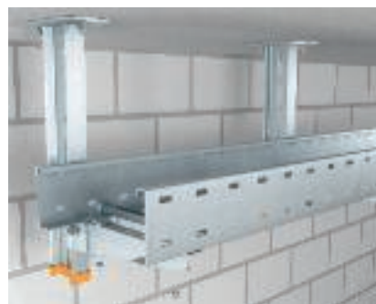
Крепление кабельного лотка лестничного типа для больших расстояний Крепление кабельного лотка лестничного типа для больших расстояний к кронштейну с помощью зажима LKS 60/5.
