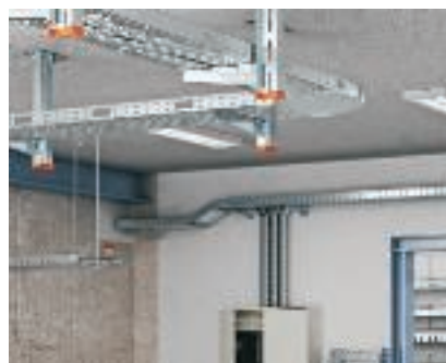
Комплексный монтаж потолочного крепления Потолочный монтаж кабельных лотков.
