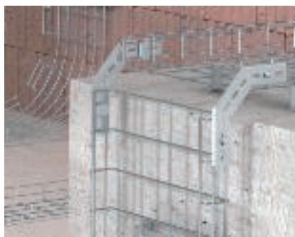
Готовый монтаж Установленный С-образный проволочный лоток.
