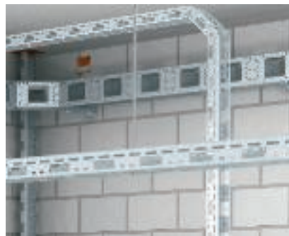
Монтаж мини-канала AZ Подвесной монтаж мини-канала AZ с помощью стержня с резьбой, а также переход из горизонтальной плоскости прокладки в вертикальную.
