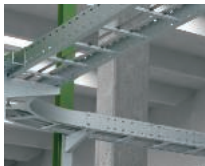
Монтаж стального зажима Монтаж системы для больших расстояний на стальных балках.
