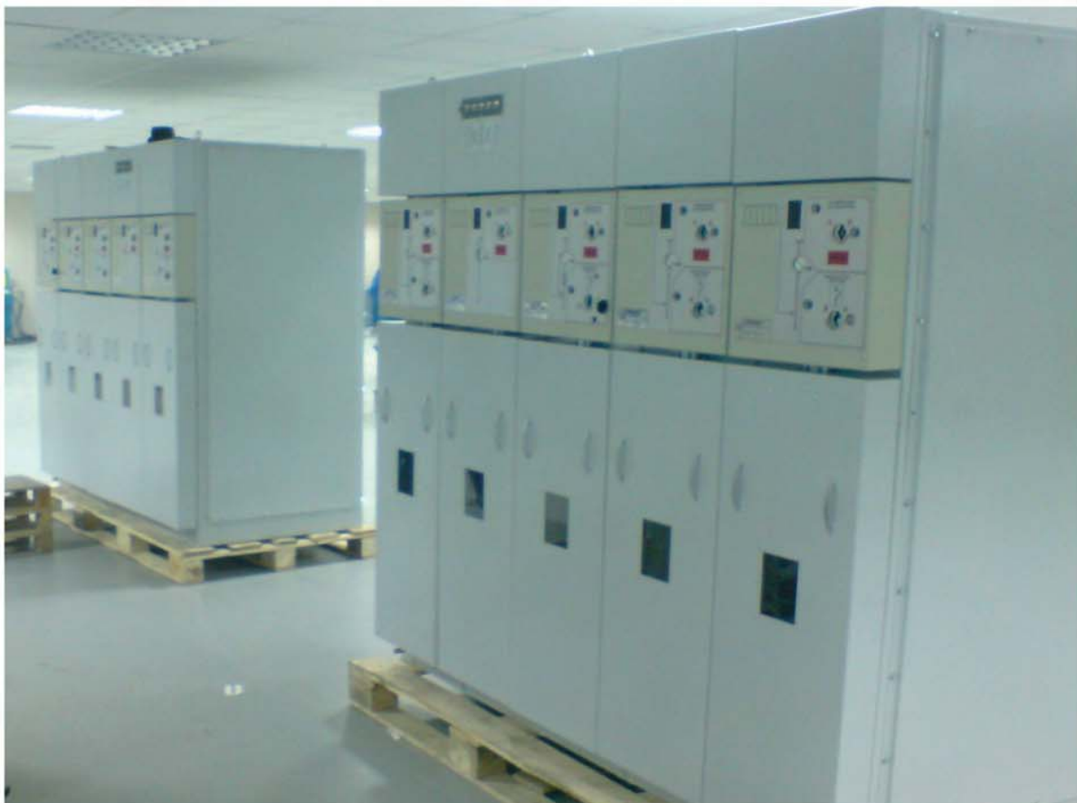
Рис. 2.1.7 Пример типового решения однорядного распределительного устройства из ячеек КСО-207-Оскол с выключателями нагрузки на вводах и отходящих линиях
