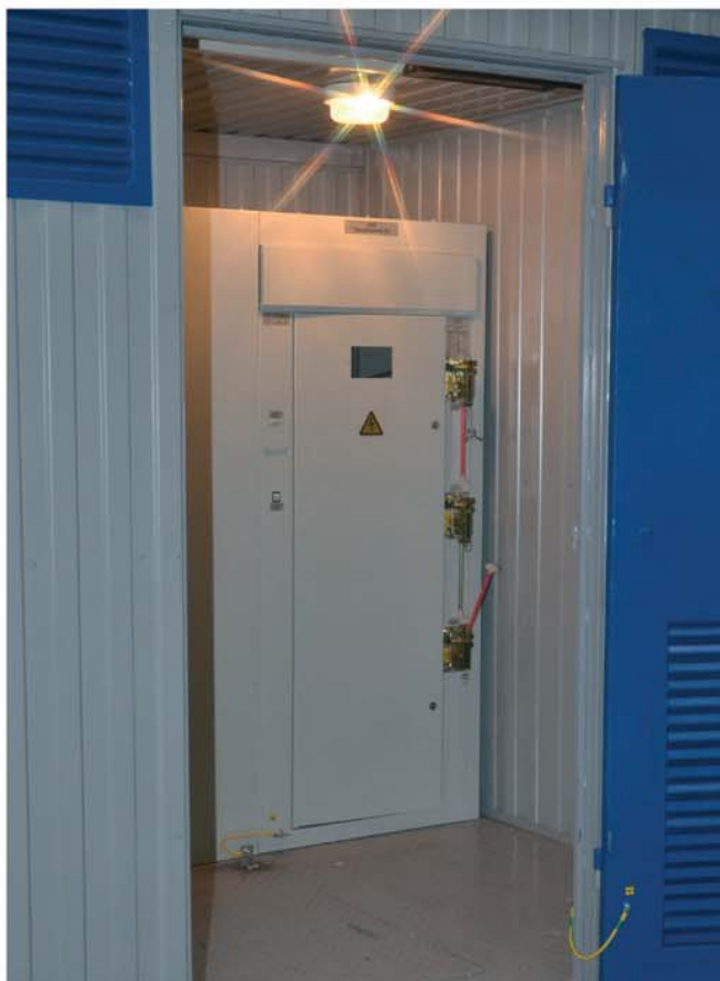
б) отсек РУ-10 кВ
