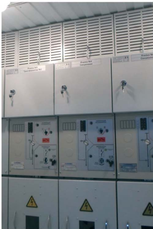
б) отсек РУ-10 кВ
