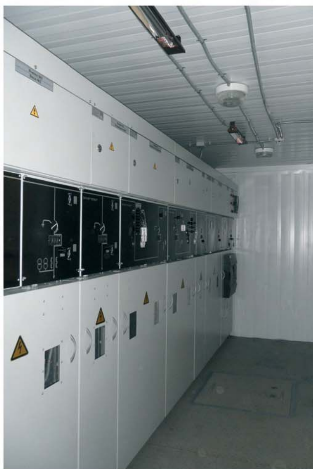
б) отсек РУ-10 кВ
